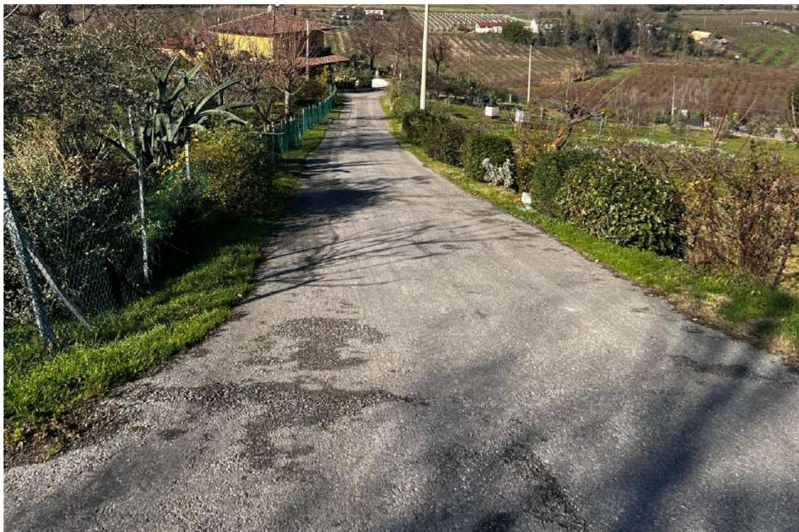
TRATTO 1 – VIA RIGONE TRATTO ASFALTATO DOPO DIRAMAZIONE
