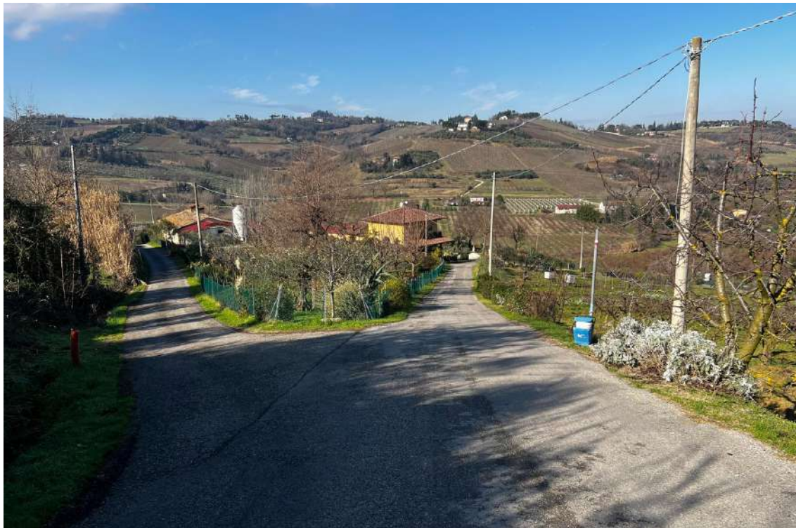
TRATTO 1 – ORIGINE DIRAMAZIONE VIA RIGONE
